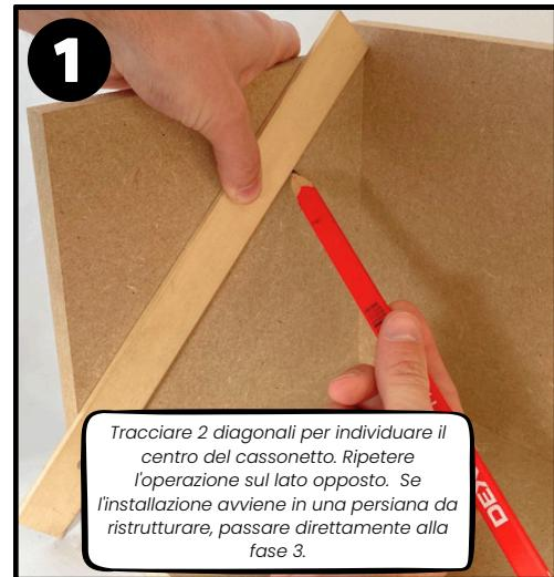
Tracciare 2 diagonali per individuare il centro del cassetto. Ripetere l'operazione sul lato opposto. Se l'installazione avviene in una persiana da ristrutturare, passare direttamente alla fase 3.
