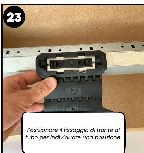
Posizionare il fissaggio di fronte al tubo per individuare una posizione.
