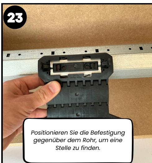
Positionieren Sie die Befestigung gegenüber dem Rohr, um eine Stelle zu finden.
